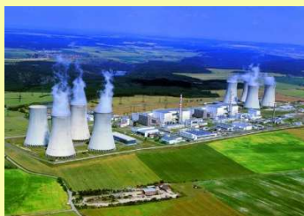
Letecký snímek Jaderné elektrárny Dukovany nacházející se na Třebíčsku.
